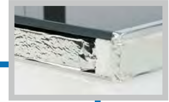
Das Bild zeigt einen Anschnitt, die EPS-Einleimer sind umlaufend.
